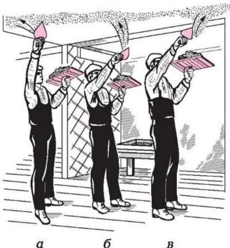
Сурет. 4.25. Ерітіндіні сылақ күрекшесімен төбеге лақтыру:
