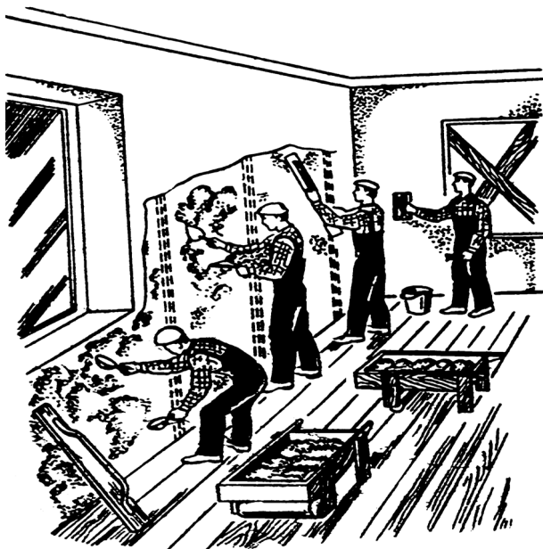
32-сурет. Төрт адамнан тұратын звеномен сылақ жүргізу
