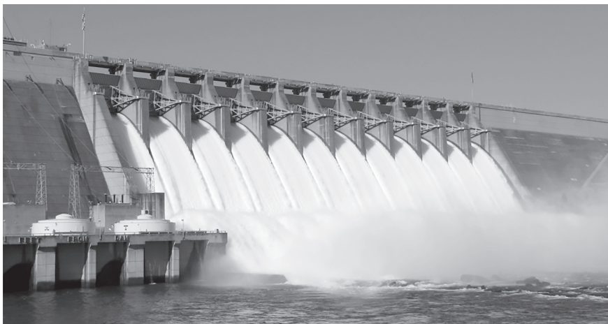
3-сурет. Су электр станциясы
